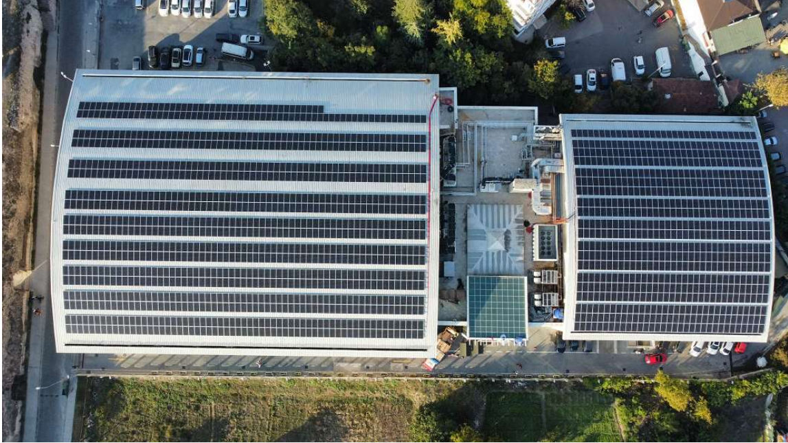
Görsel 13 Çatı PV uygulaması
