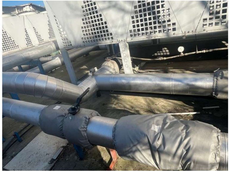
Görsel 10 Soğutma grubu modernizasyonu
