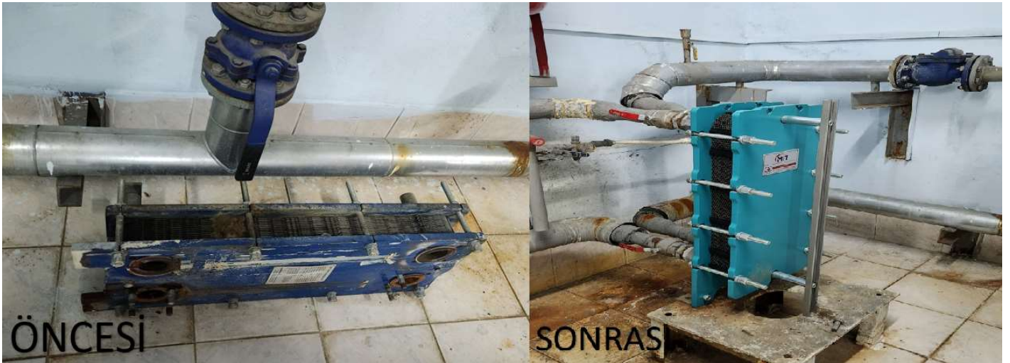
Görsel 11 Eşanjör değişimi uygulaması
