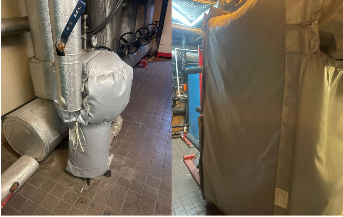
Görsel 7 Vana ceketi ve tesisat yalıtımı uygulaması
