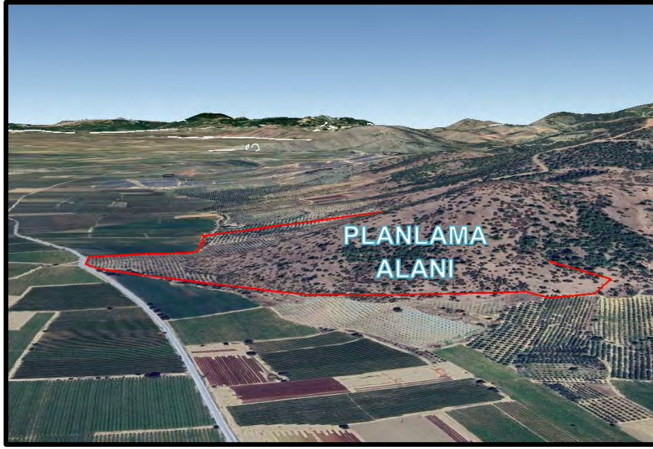
Şekil 7 Alanın Mevcut Durumu
