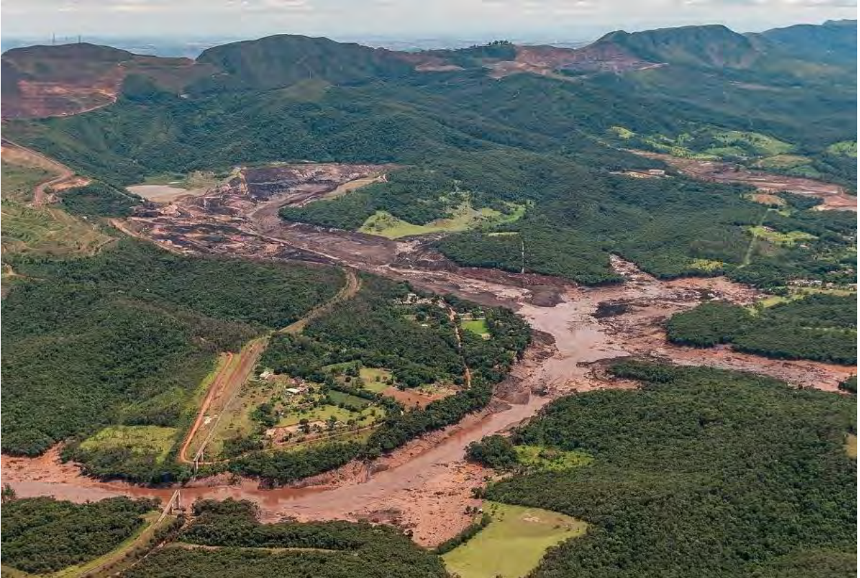
Şekil 24: Vale Brumadinho Atık Barajı Kazası
